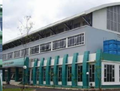
Gedung Olahraga STTD Cibitung
