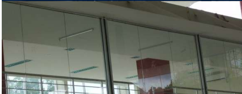
Gedung Diklat Pandeglang Serang
